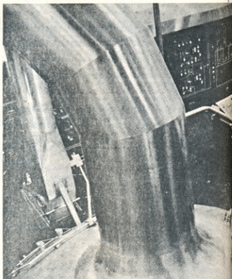
Na operação de fermentação — Nesta cervejaria de Houston County, existe um sistema eletrônico de dosagem de ingredientes. Apesar de trabalhar com apenas dois fluxos de ingredientes, o sistema digital mantém-se ocupado sequenciando o fluxo de entrada e saída dos reservatórios de fermentação, temporizando os agitadores, controlando a temperatura e alertando o operador, quando as condições ultrapassam os limites estabelecidos.
